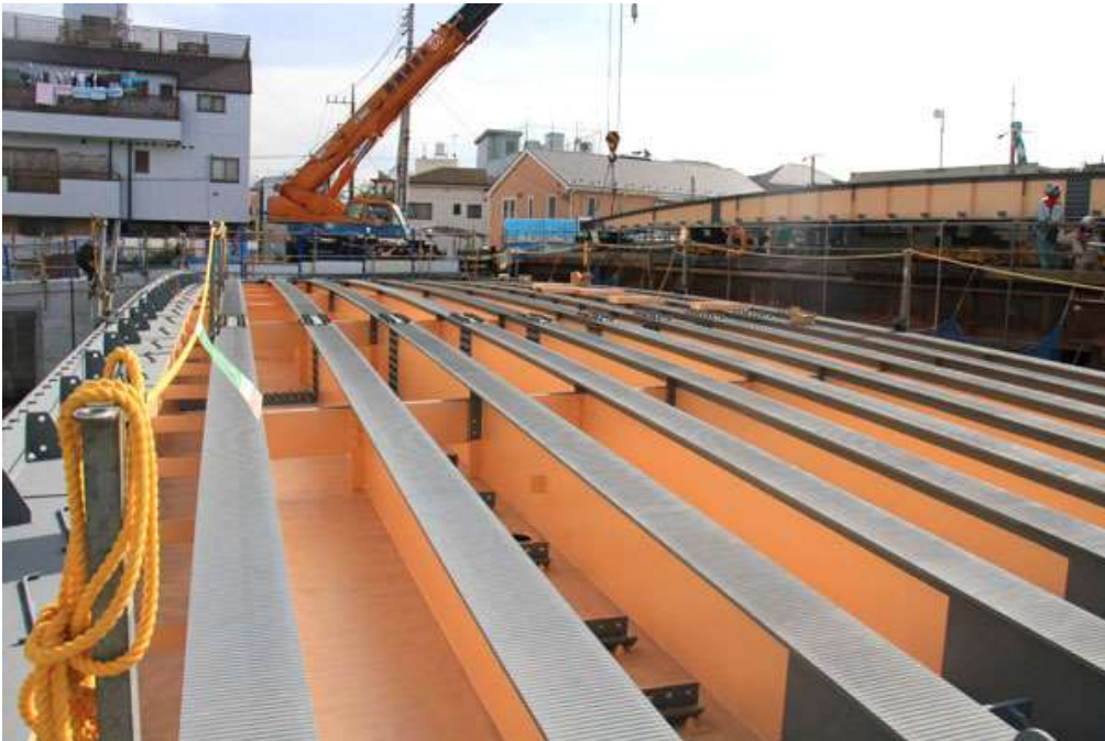
(八幡橋橋桁 b2012i5099s)
