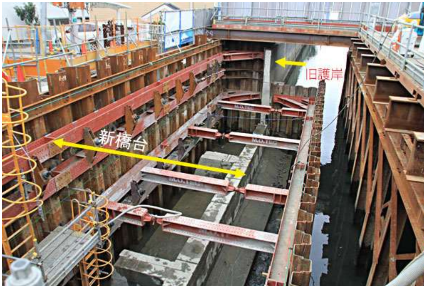
(八幡橋橋台 a2010i8507s)
