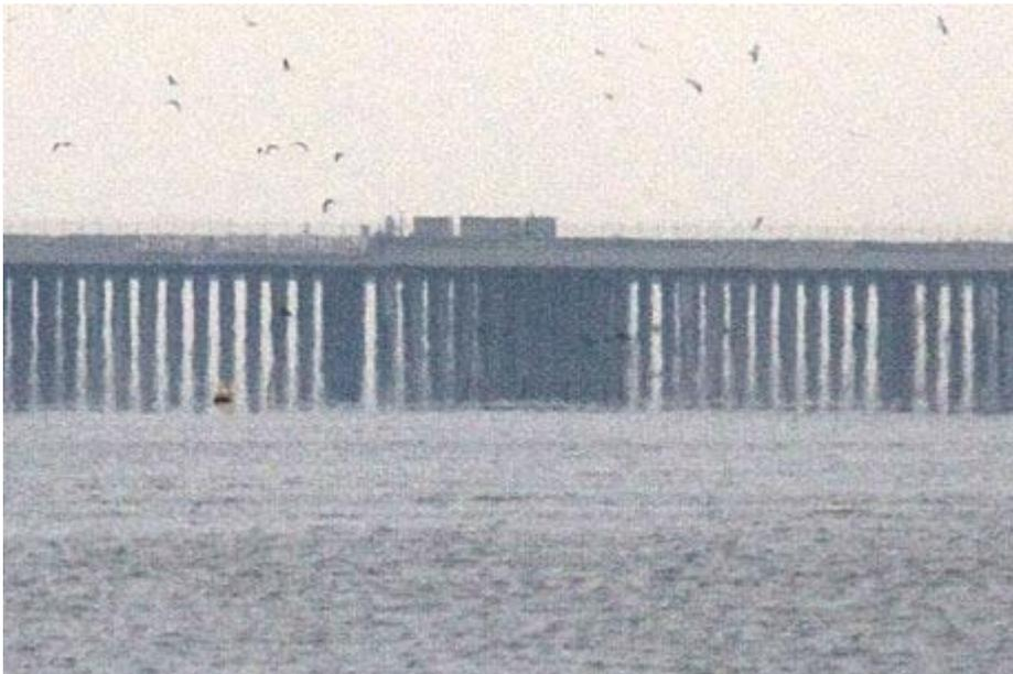
天候が悪いのと、あまりにも船から遠いので、写真が汚くて申し訳ないのですが、「D滑走路」の写真を拡大して見ると、滑走路が「杭」で浮いているのが判ります。
